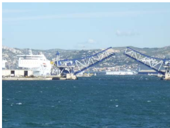
マルセイユ港内の航路を横断する跳ね橋
