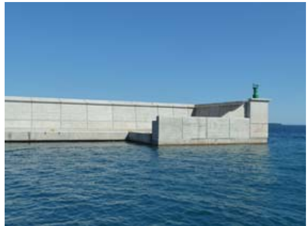
バレンシア港の新設ケーソン式防波堤
