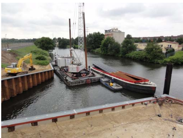
エルベ川支流側係留杭打設
